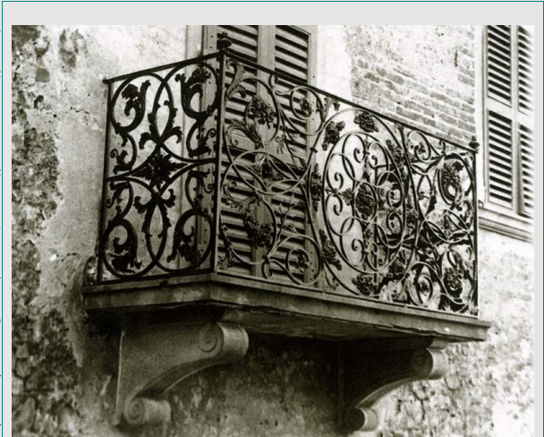
Ringhiera del balcone di palazzo Zanchi, opera del Leomazzi
